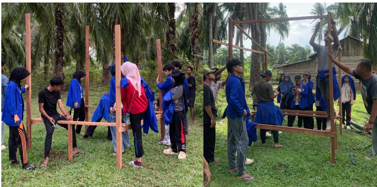
Gambar 2. Pembangunan Dapur Siaga Bencana
