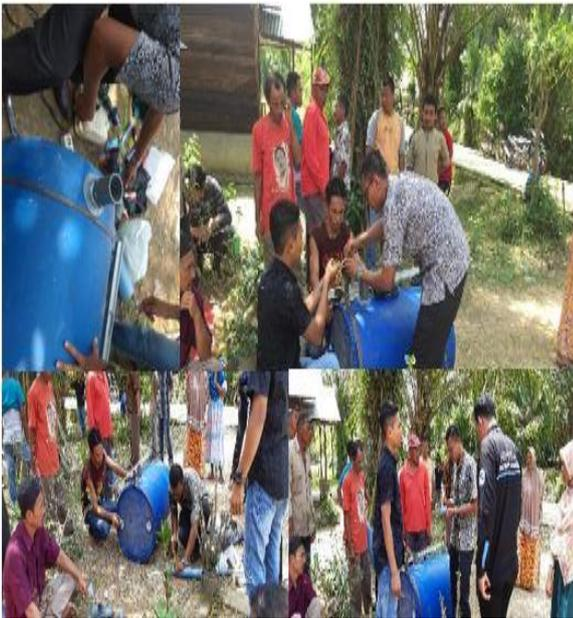
Letak keluar gas dipasang pada tutup drum dengan membuat lubang untuk dimasukkan sock drat  $\frac{1}{2}$  inch. Alat ukur tekanan ditanamkan di atas drum dengan proses yang sama seperti tempat keluar gas. Agar kapasitas gas yang dihasilkan biogas terjaga maka pada masukan limbah kandang ternak dan keluaran gas dipasangkan stop kran. Setiap penyabungan dilakukan pengeleman pada sambungan pipa maupun yang tertanam pada drum. Instalasi digester biogas portable ditunjukkan pada Gambar 6.
