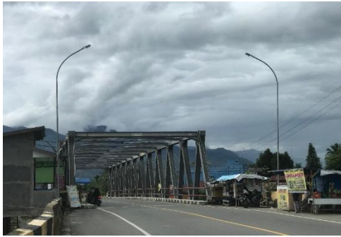
Gambar 2. Jembatan Desa Natam Menuju Desa Natam Baru Yang Rusak Sudah Diperbaiki
