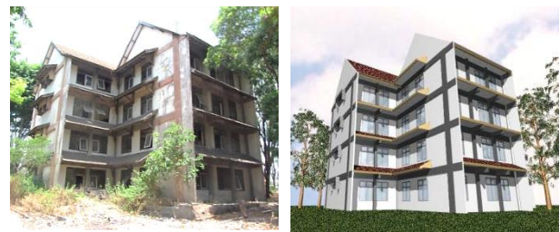
Gambar 13. Tampak Gedung A sebelum (kiri) dan setelah (kanan) rehabilitasi
