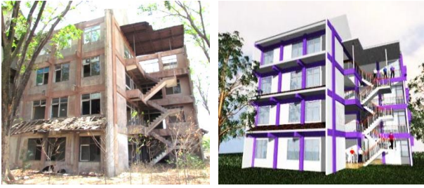
Gambar 16. Tampak Gedung D sebelum (kiri) dan setelah (kanan) rehabilitasi
