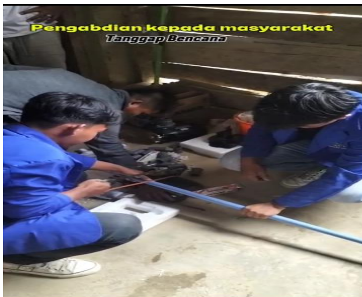
Gambar 2. Pemotongan pipa sesuai ukuran untuk pemasangan pada sumur
