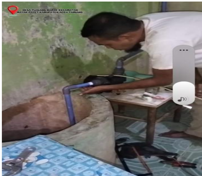
Gambar 4. Pemasangan mesin pompa air pada sumur
