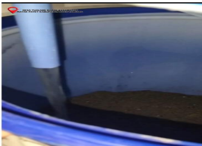
Gambar 5. Proses pemompaan air sumur menuju saringan (drum filter)
