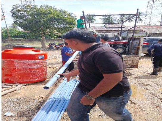
Gambar 5. Persiapan material perpipaian dan komponen pendukung sistem filtrasi
