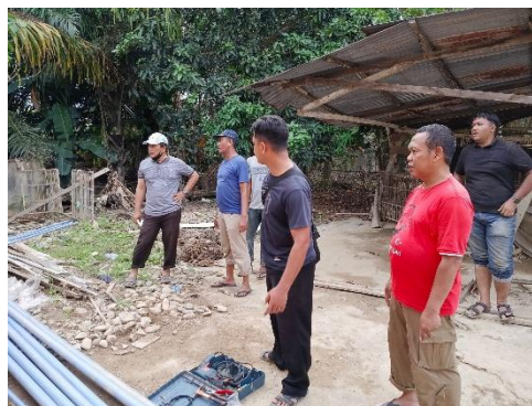
Gambar 6. Persiapan Lokasi dan Pemasangan Rangka Penyangga Tandon
