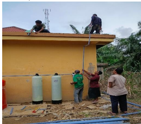
Gambar 8. Pemasangan Unit Filtrasi dan Jaringan Perpipaan
