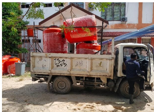
Gambar 4. Pengangkutan tandon penampungan dan rangka penyangga menuju lokasi kegiatan
