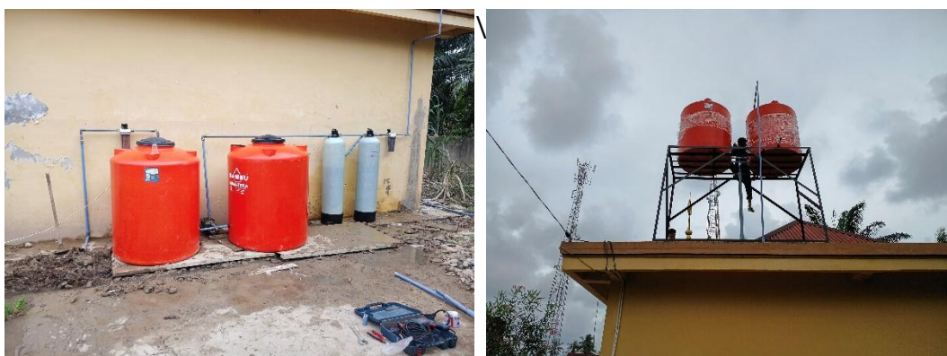
Gambar 10. Sistem penyediaan air bersih yang telah selesai dipasang dan siap dioperasikan
