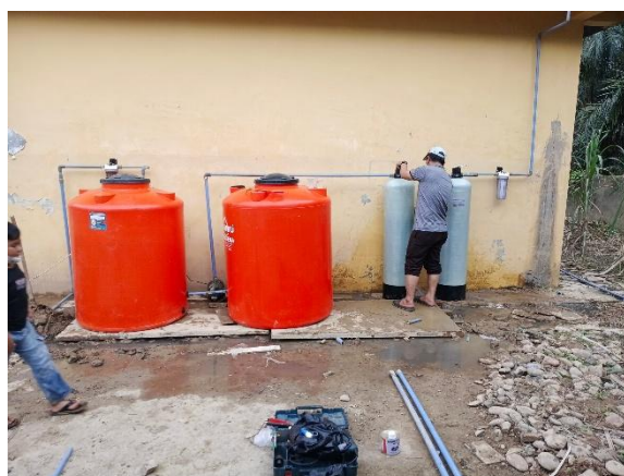
Gambar 9. Pemasangan Tandon Penampungan dan Penyelesaian Sistem
