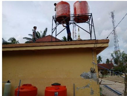
Gambar 7. Pemasangan Tandon Distribusi pada Rangka Penyangga
