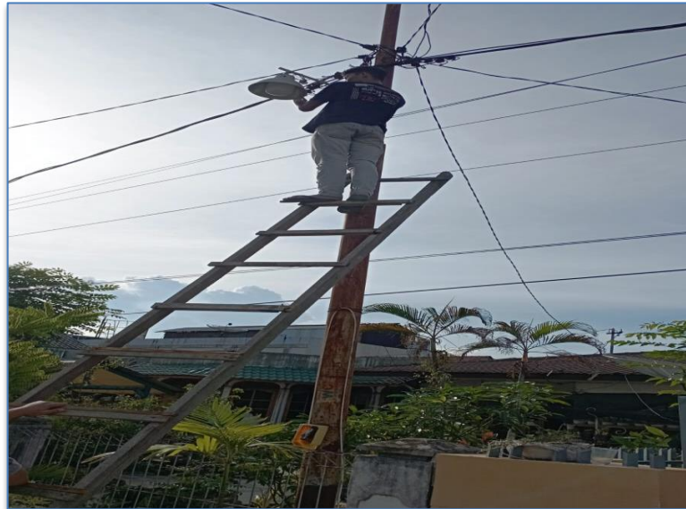
Gambar 3 : Pemasangan Photocell
